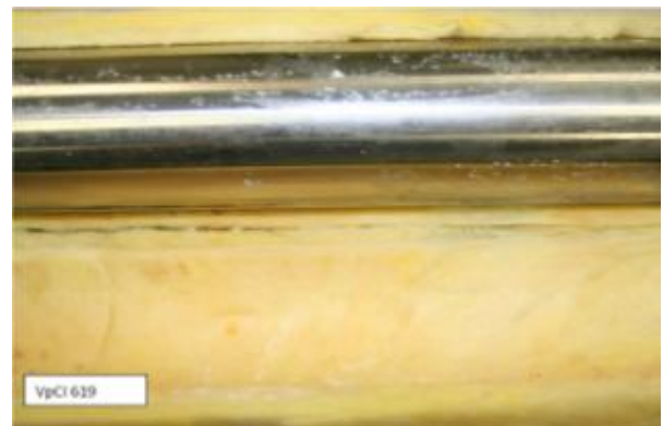
Tubo protegido por VpCI-619 después de 240 horas de prueba en condiciones de alta temperatura con una inyección normal de cloruro.
