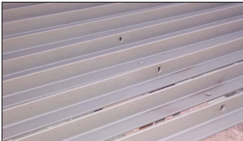
Aplicación de imprimación intermedia de óxido de hierro micaceo:
