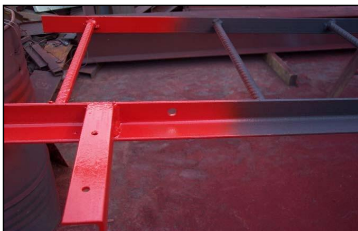
Aplicación de recubrimiento poliuretano alifático con inhibidores Q-365E:
