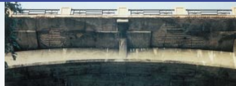
Remueva el hormigón desprendido de la estructura deteriorada.
