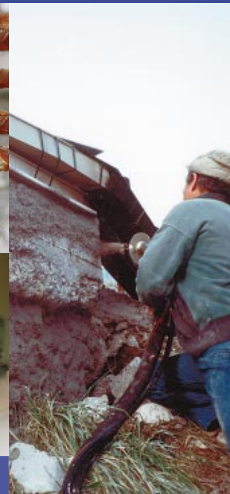
Remueva el hormigón desprendido de la estructura deteriorada.
