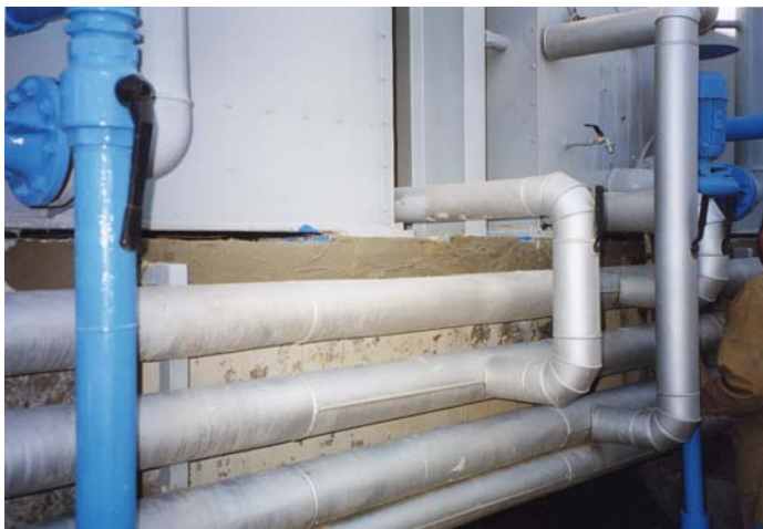
Aspecto de la reparación de los soportes.
