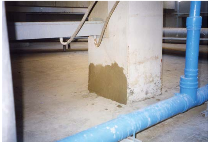
Aspecto de la reparación de los soportes.
