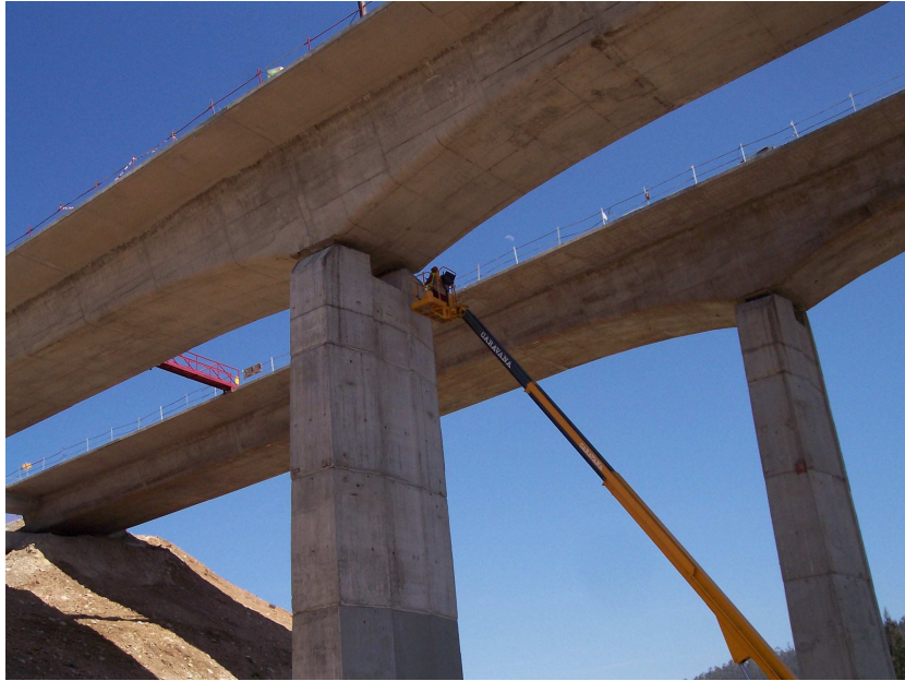
Momentos de la aplicación del inhibidor MCI-2021
