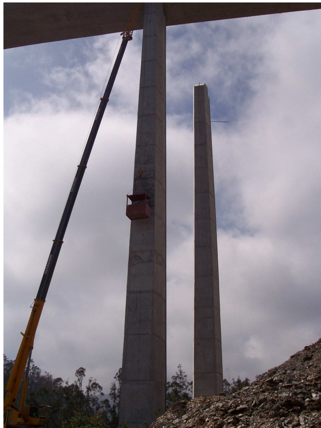
Momentos de la aplicación del inhibidor MCI-2021
