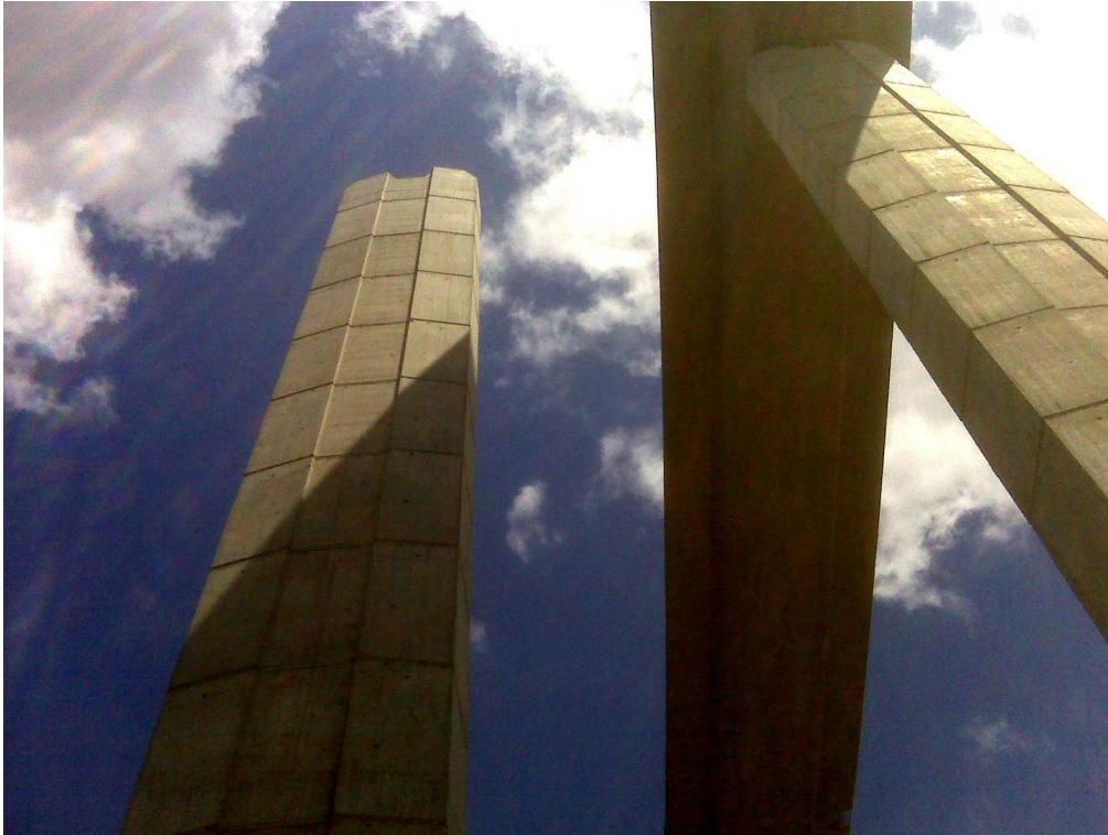
Uno de los pilares protegidos.
